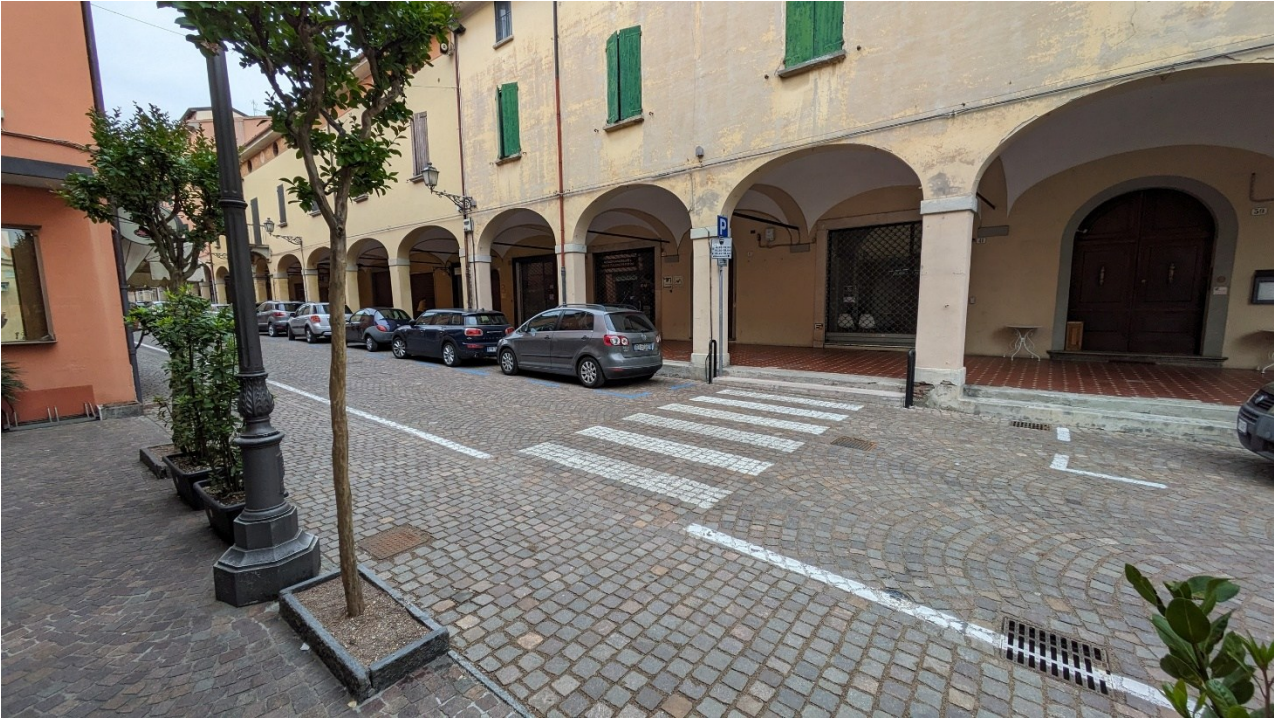
Figura 11 - Ripresa fotografica del portico in via Mazzini.
